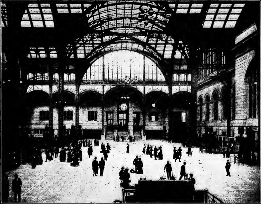
Ein moderner Bahnhof.
